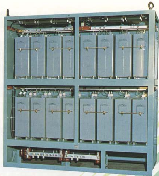
Figura 13. Caja del condensador del filtro principal
