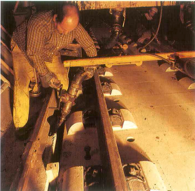
Montaje de Vía en placa, Línea II del FCMB
