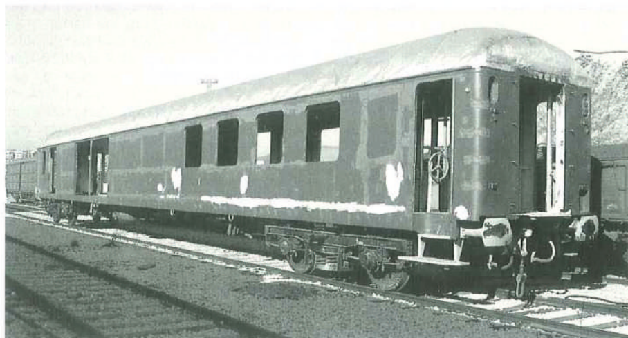
Uno de los dos coches híbridos RGH 15400 transformados por TMOINSA para el Charrén, visto, en pleno proceso de transformación, en el TMR de Barcelona-Can Tunis. (Foto: Carlos Ortí Ortega, 24.12.1991).
